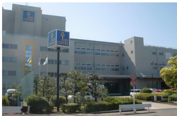
中部工場外観
