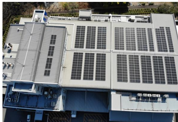
設置した太陽光パネル
